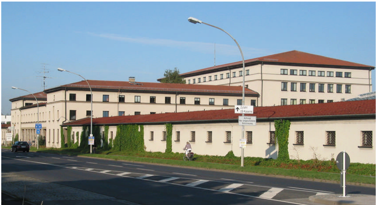
Die frühere „Hauptwerkstätte für Postkraftwagen“ (HWKW), erbaut 1923-25, nach schwerer Kriegsbeschädigung 1955 wiederaufgebaut, als Beispiel für einen Zweckbau der zwanziger Jahre des 20. Jahrhunderts. Foto: Dengler-Schreiber 2006
